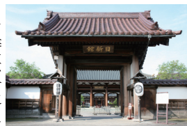
昭和62年、完全復元された会津藩校日新館
